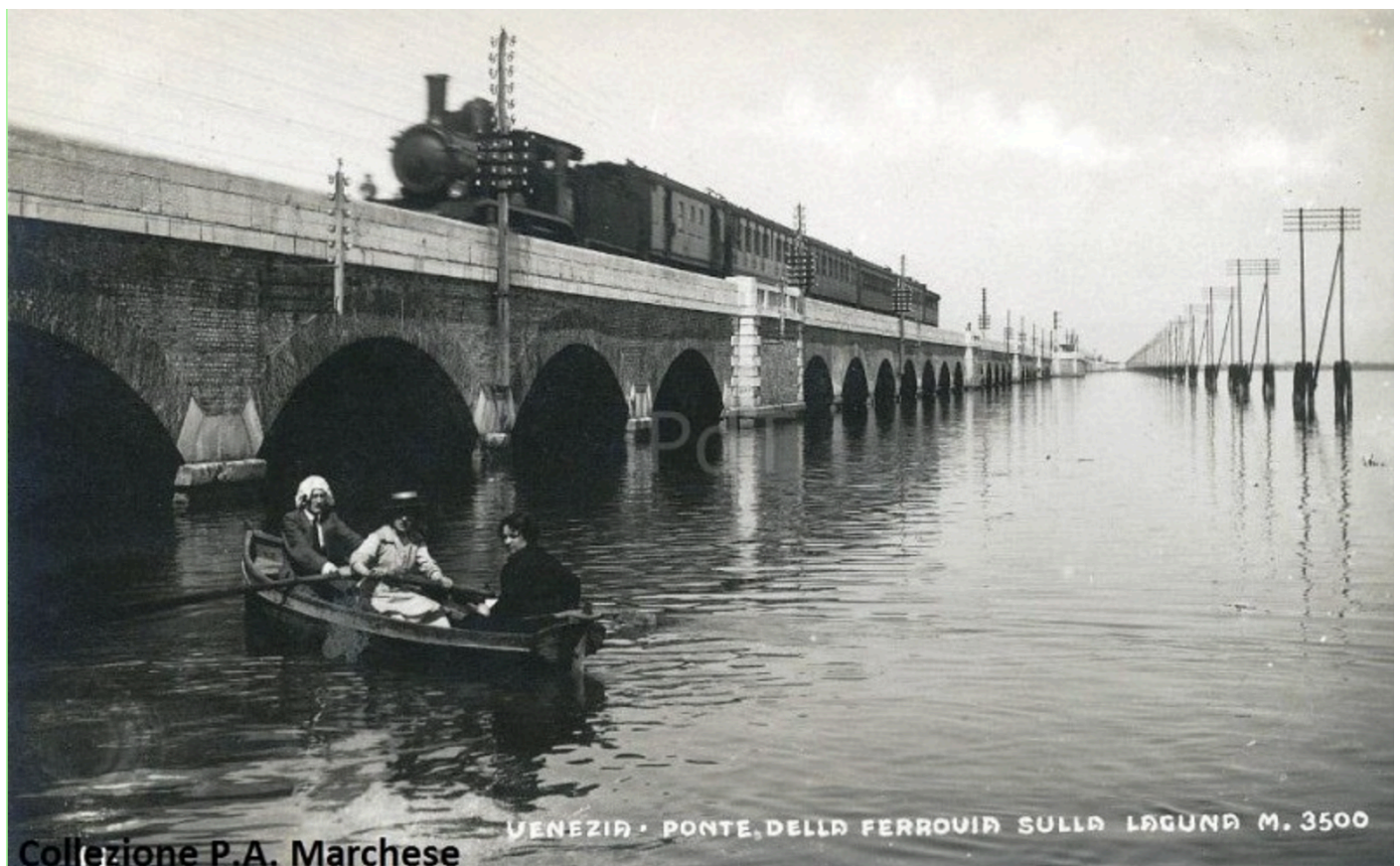
Figura 4 Ponte ferroviario translagunare. Fonte: Collezione P.A. Marchese
