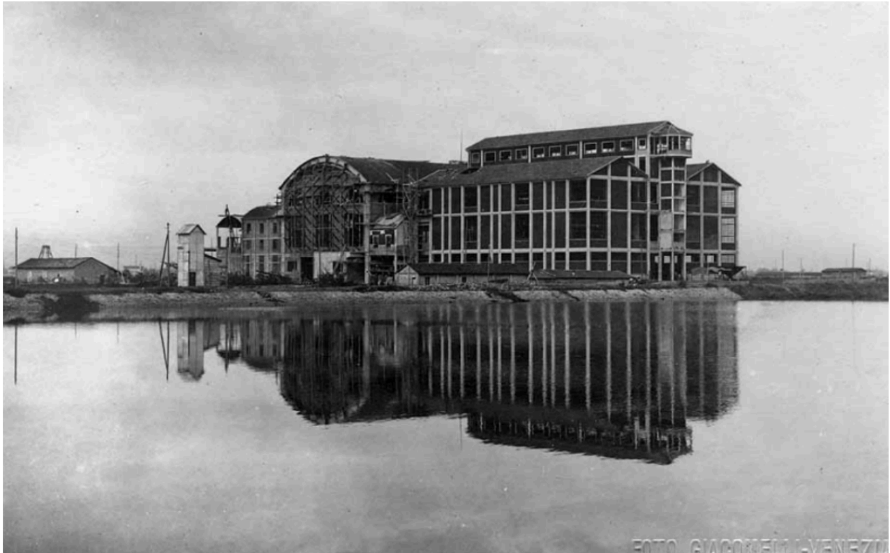
Figura 21 Porto Marghera, centrale termoelettrica SADE., lo stabilimento in costruzione, 1926. Fonte: Fondo Giacomelli
